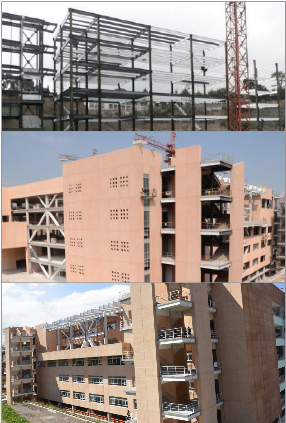
Figura 25. Imágenes del progreso de la construcción de la Torre III.
