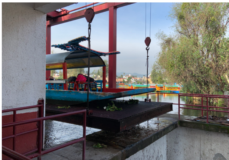
(Fotografía N.º 2, “Parrilla metálica en la esclusa de Caltongo”, Gómez 2019)
