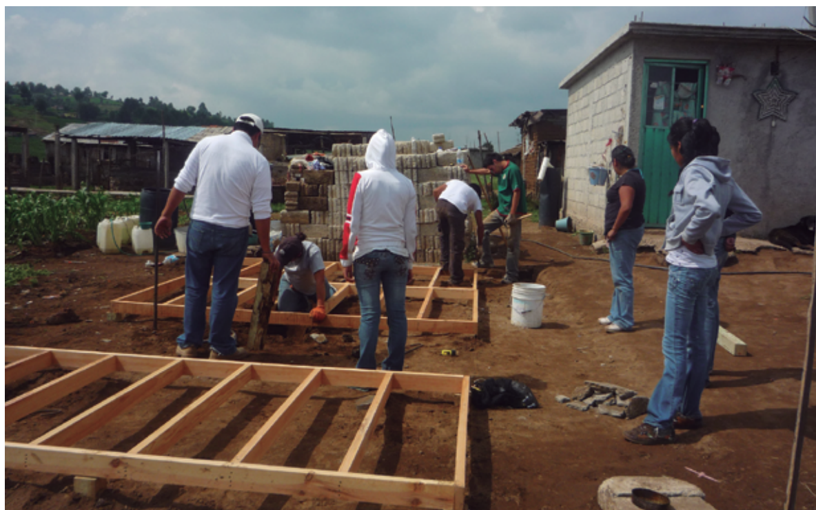
Imagen 1. Construcción de casa en San José del Oro, Estado de México.
