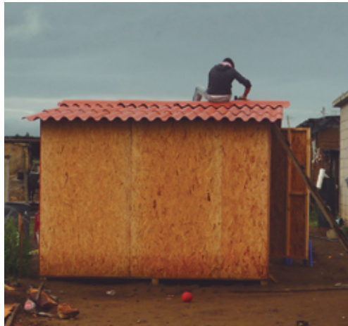
Imagen 2. Construcción de casa en San José del Oro, Estado de México.
