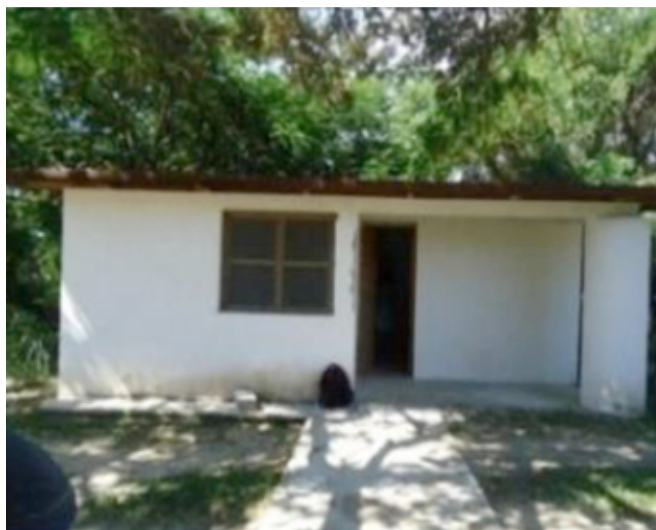
Figura 2. Prototipo A. FADU Adobe. Dos plantas. Superficie aproximada por planta, 40 m 2 . Fuente: archivo fotográfico propio. Planos proporcionados por el ITADU FADU
